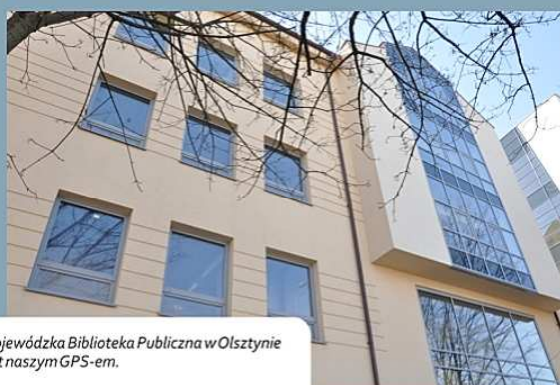
Budynek przy ul. 1 Maja 5 WBP w Olsztynie
